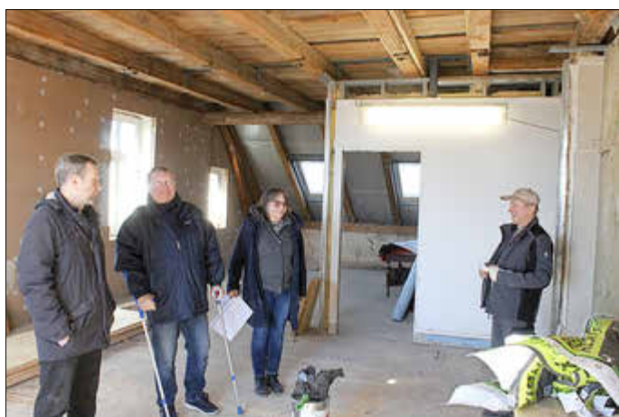
Das Pfarrhaus Ducherow wird zur Zeit modernisiert. Auf dem Bild ist eine Baubesprechung der Experten zu sehen.
