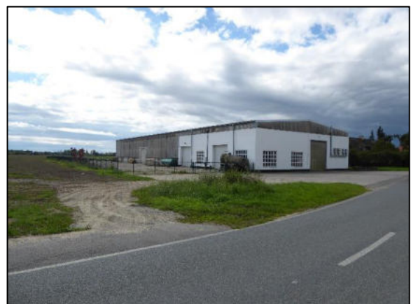
Abbildung 15: Südwestlich gelegene Halle
