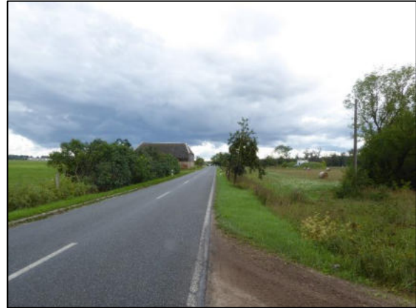
Abbildung 5: Westliche Blickrichtung Richtung Boldekow, Zufahrt
