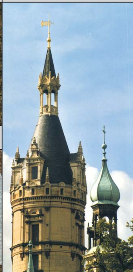
Hochpunkt (Turm Knopf u. a.)
