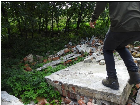
Abbildung 13: Großflächiger Mauerbruch mit zahlreichen Versteckmöglichkeiten.
