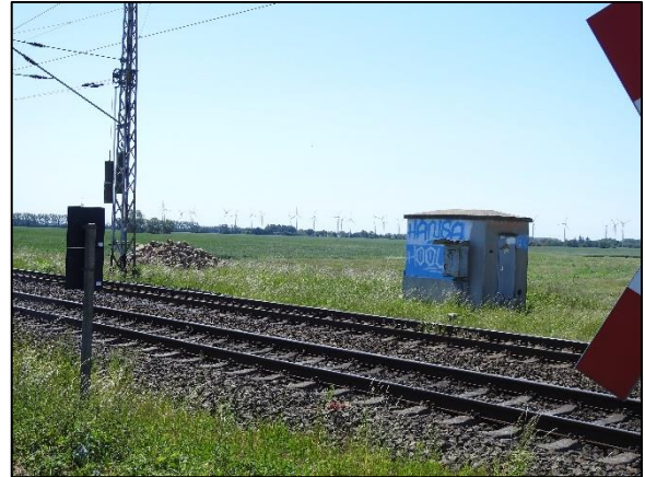
Abbildung 16: Bahntrasse zwischen den Planteilen.
