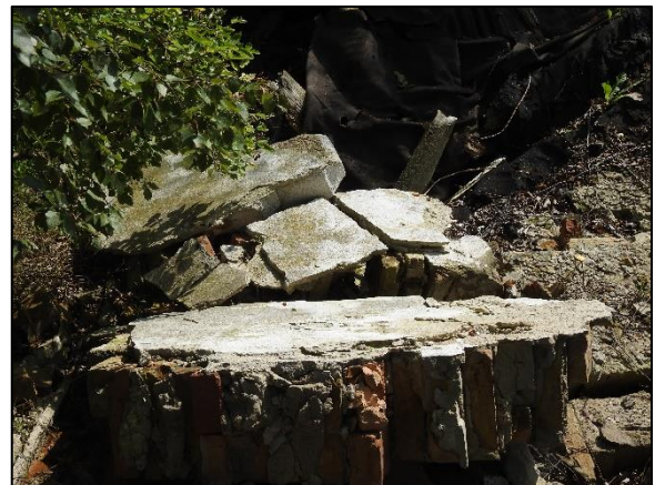
Abbildung 14: Untersucher Mauerbruch, inklusive Sichtung der Unterseite, wenn möglich.
