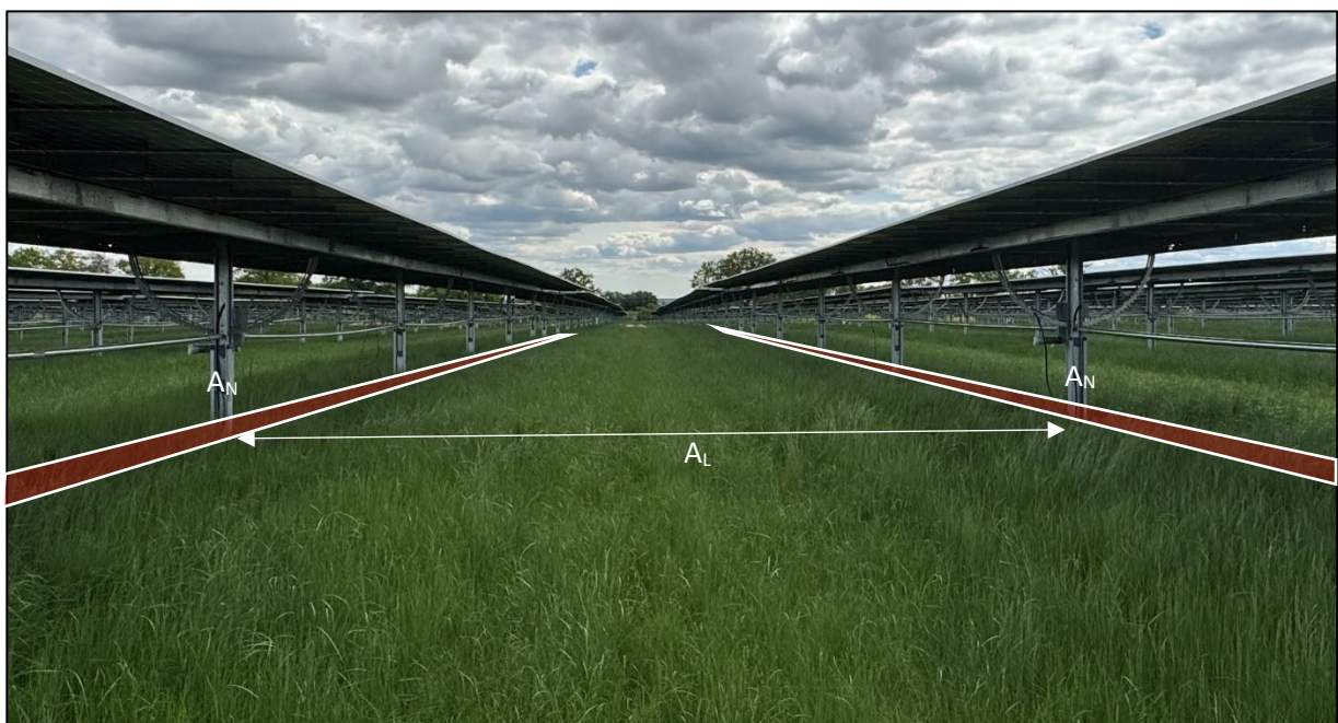
Abbildung 12: Beispiel einer Agri-PV-Anlage mit nachgeführten Horizontaltrackern in der Gemeinde Tützpatz, Vorhabenträger Vattenfall, Vorhabenstandort Tützpatz, Foto: Leddermann – Mai 2025
