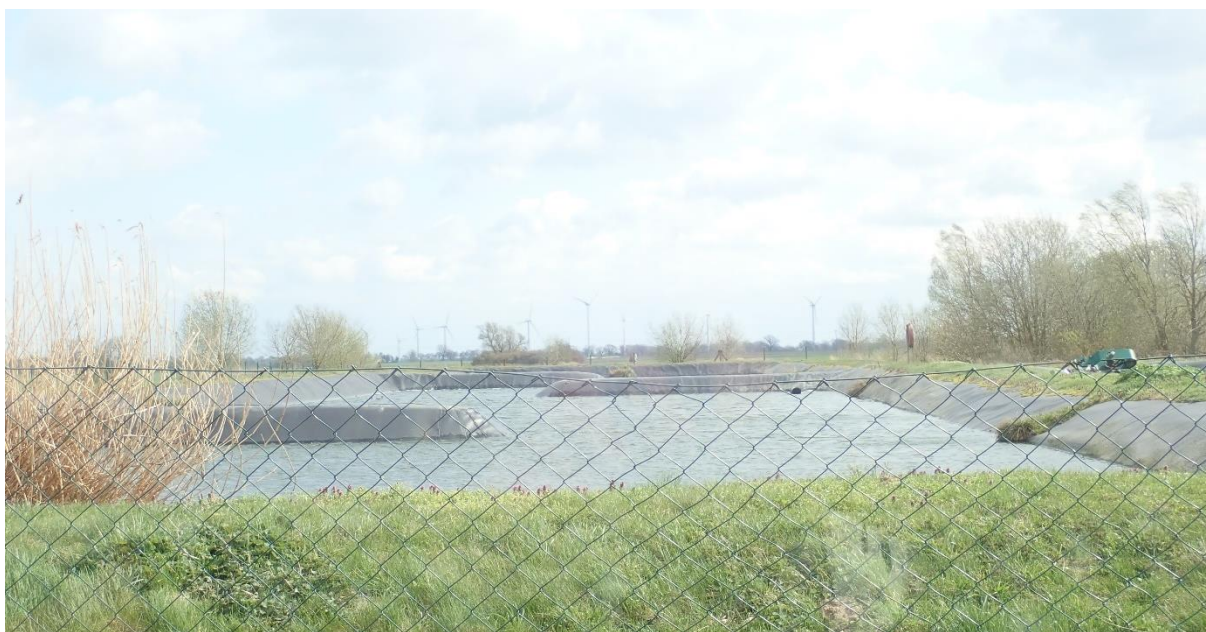
Bild 01: Regenrückhaltebecken nördlich des Plangebietes
