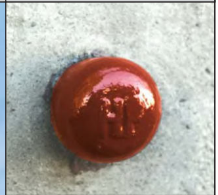
HFP Mauerbolzen (Ø 2 cm bis 5,5 cm) oder Höhenmarke
