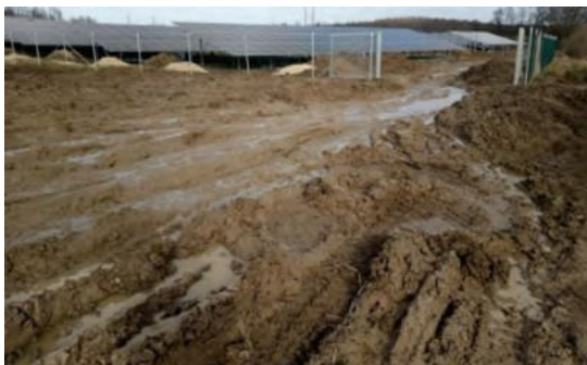
Foto 1-3: Befahrung ungeschützten Oberbodens bei ungeeigneter Witterung/Bodenfeuchte führt zu Schädigung des Bodengefüges und schränkt die Funktionsfähigkeit des Bodens ein
